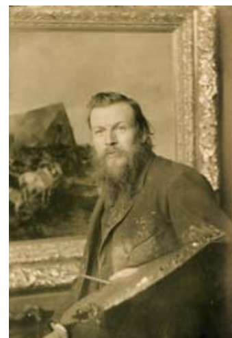
Im Atelier vor dem Bild "Alter Fischmarkt bei Reval"
